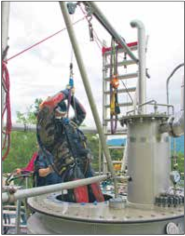
Industrietaucher zieht beim Faulturm Sedimentproben. [Uni Innsbruck]
